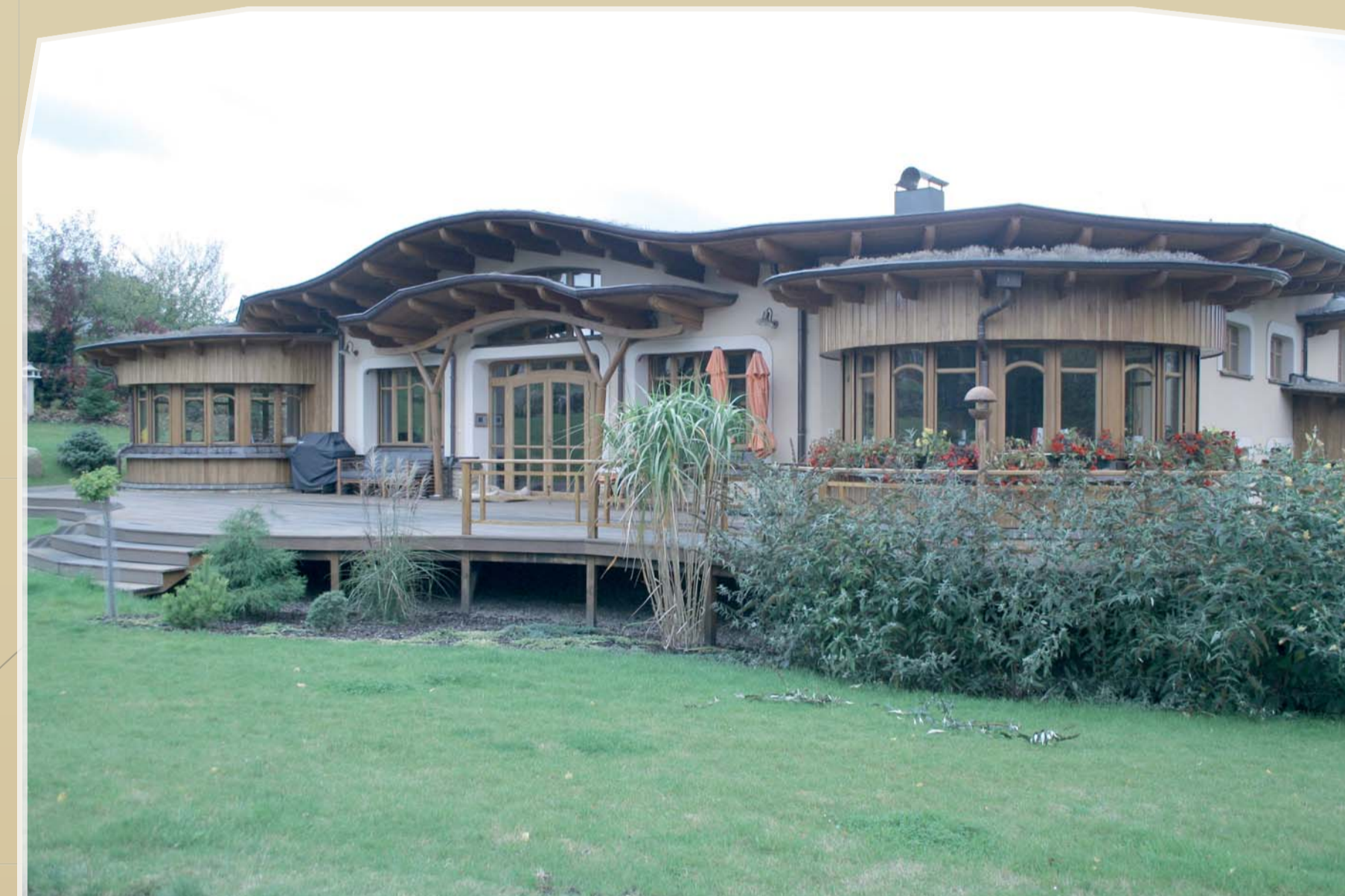
Provětrávané podlahy, ochrana proti radonu Ventilated floors, protection against radon Ventilierte Fußböden, Schutz vor Radon Полы с вентиляцией, защита от радона
