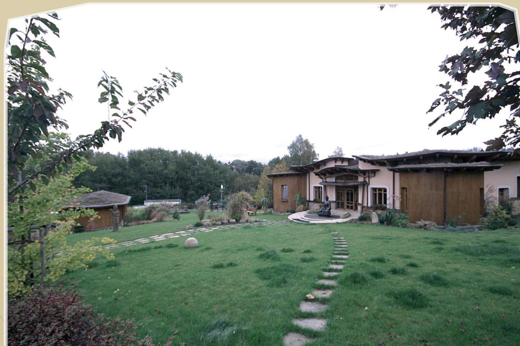
Citlivé umístění staveb do terénu Sensitive integration of building into terrain Behutsame Einfügung der Bauten ins Gelände Деликатное вписывание строений в природную структуру
