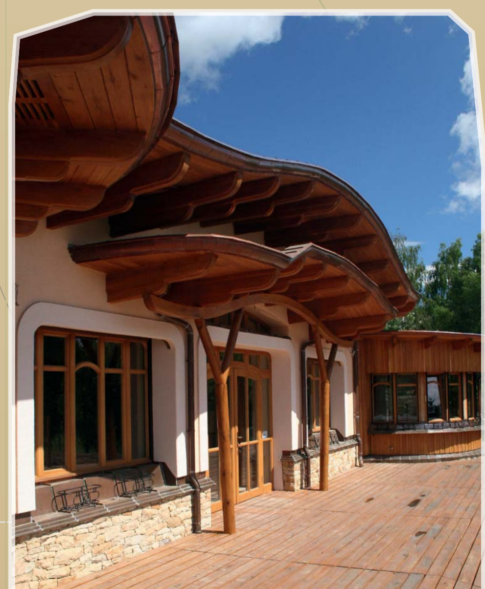
Přirozené stínění střechami stavby Natural shielding by roof of the building Natürliche Beschattung durch die Dächer des Hauses Естественное затенение крышами постройки
