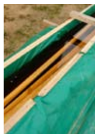
Smrkové bednění se máčí v roztoku boronitové soli
