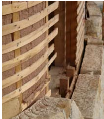
Obvodová stěna s provětrávanou vzduchovou mezerou: zprava podezdívka z pískovce, vzduchová mezera, dřevěné bednění a protivětrová zábrana z juty. Za ní bude izolační prostor vyplněný balíky slámy
