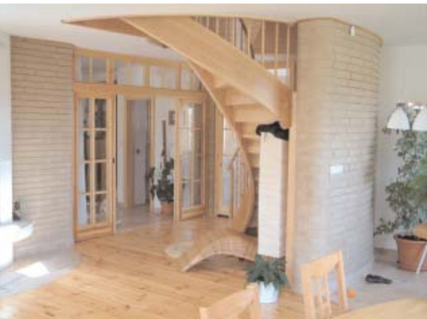
Točité schodiště podél akumulční stěny z nepálených cihel v nízkoenergetickém rodinném domku
