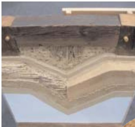
Hliněná omítka s příměsí částeček slámy natřená přírodním pigmentem
