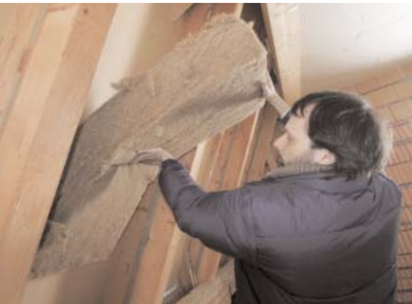
Krokve s přerušným tepelným mostem, síla krovu bude zateplena 30 cm silnou tepelnou izolací z konopných vláken
