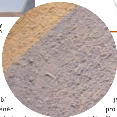
Hliněná omítka s příměsí částeček slámy natřená přírodním pigmentem
