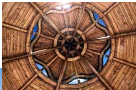
Pohled do střechy zahradního altánu
