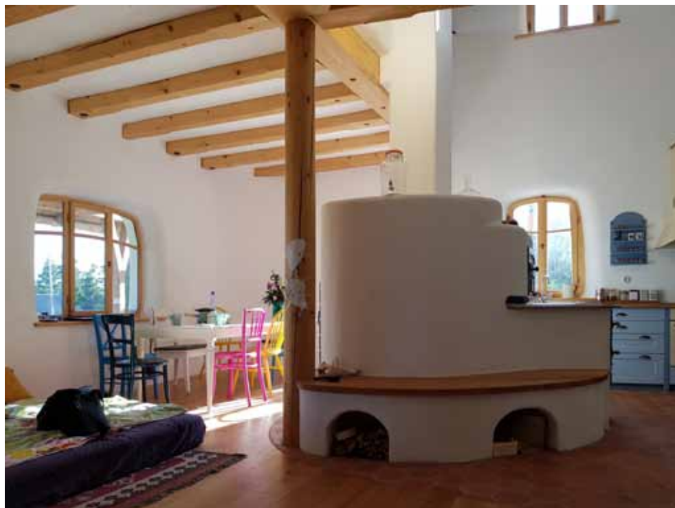
Srdcem domu je pec. Obsahuje sporák na vaření a troubu, ve druhé části pak akumulaci topeniště, které je orientováno směrem k jídelnímu stolu
