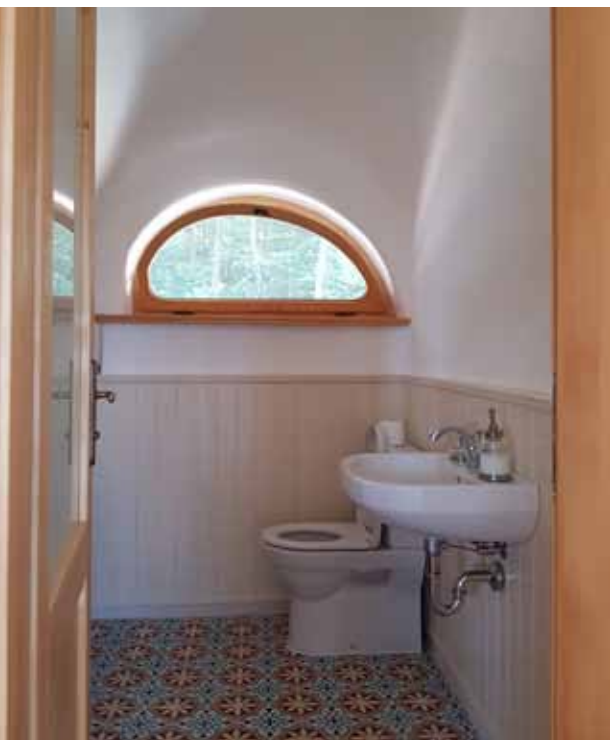
Koupelna s WC v 1. patře domu. Strop tvoří část severního zaobleného vikýře. Dveře, okna i viditelné trámy jsou natřeny přírodním olejem
