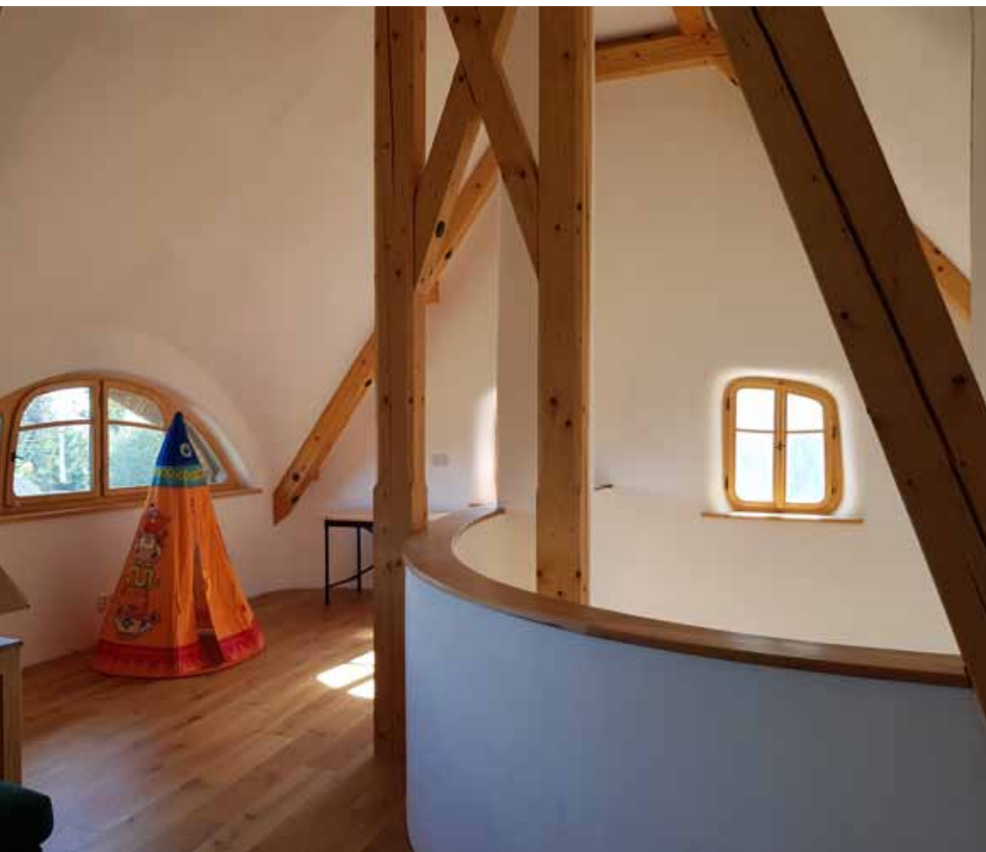
Pohled do centrální haly v prvním patře. Vpravo je otevřený prostor nad pecí, kudy stoupá teplý vzduch, proniká tudy i světlo do přízemí
